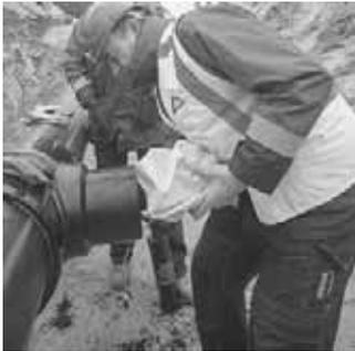
Reparaturset RPS zum Rückhalten von nachlaufendem Restwasser
